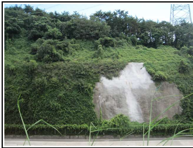
【그림 6.3.4】 보호/보강시설 전경
